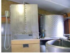
Photo 12 : chaudière de type 1 e PERCY couplée à un réservoir de stockage en inox à pression atmosphérique.
