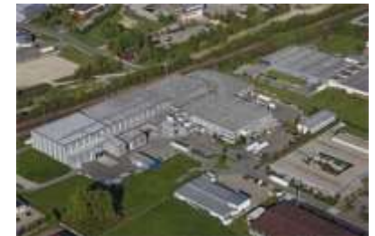
Site industriel et logistique de CDS Hackner
